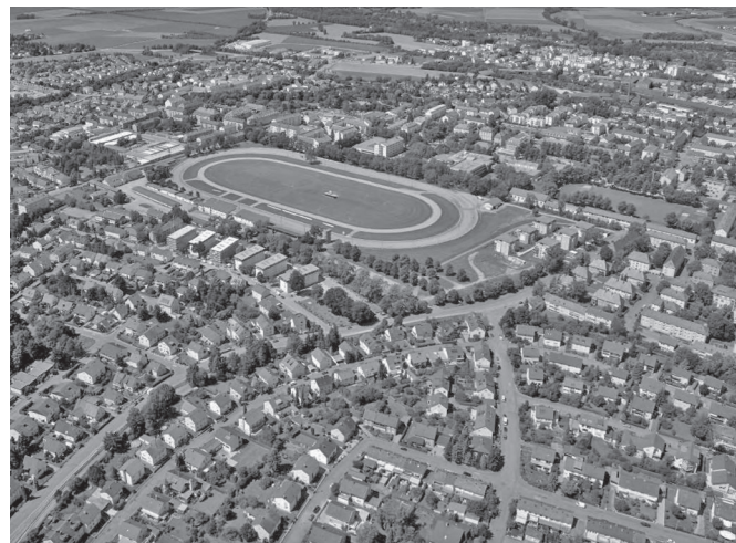
Luftbild mit Blick von Südosten auf die Trabrennbahn mit umliegender Bebauung, um 2010 (Stadt Straubing | Stadtplanung)
